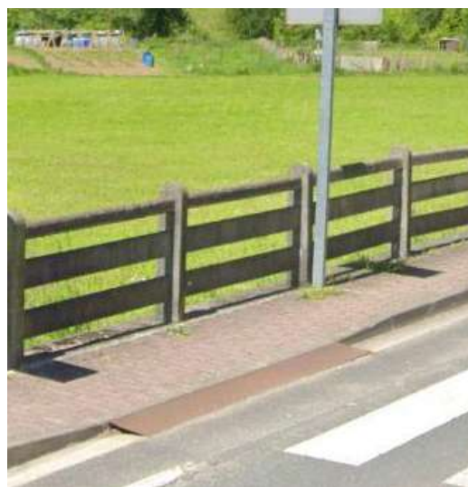
Goratutako zebra-bideek oinezkoen ibilbidea errazteaz gain, malda leunegia ez denean, ibilgailuen abiadura moteltzen laguntzen dute.
