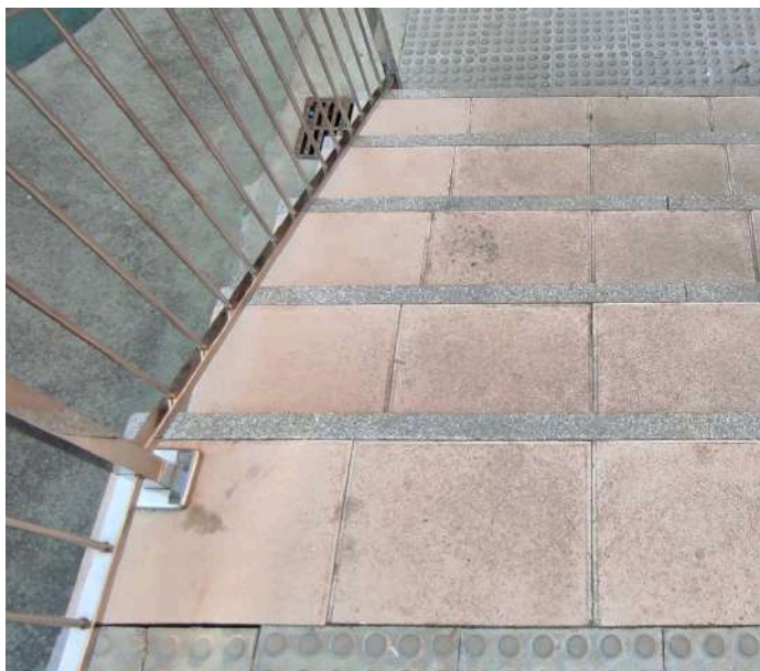
Kromatikoki desberdidutako mailek segurtasun baldintzak areagotzen dituzte.
