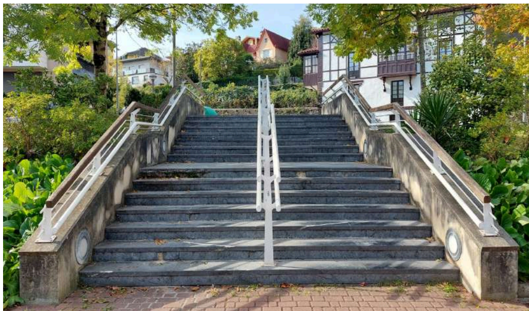
Eskubanda bikoitza eskaileraren erdian. Alboetako eskubanda, aldiz, bakarra da eta ez da ergonomikoa.
