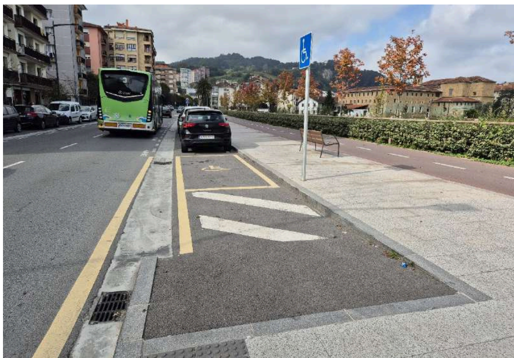
Goiko bi irudietan: Aparkaleku egokitua ilaran: transferentzia-eremua zebra-bide aldera jarri da, ibia bertan eraiki delarik, asfaltozko arrapala baten bitartez. Zarautz.
