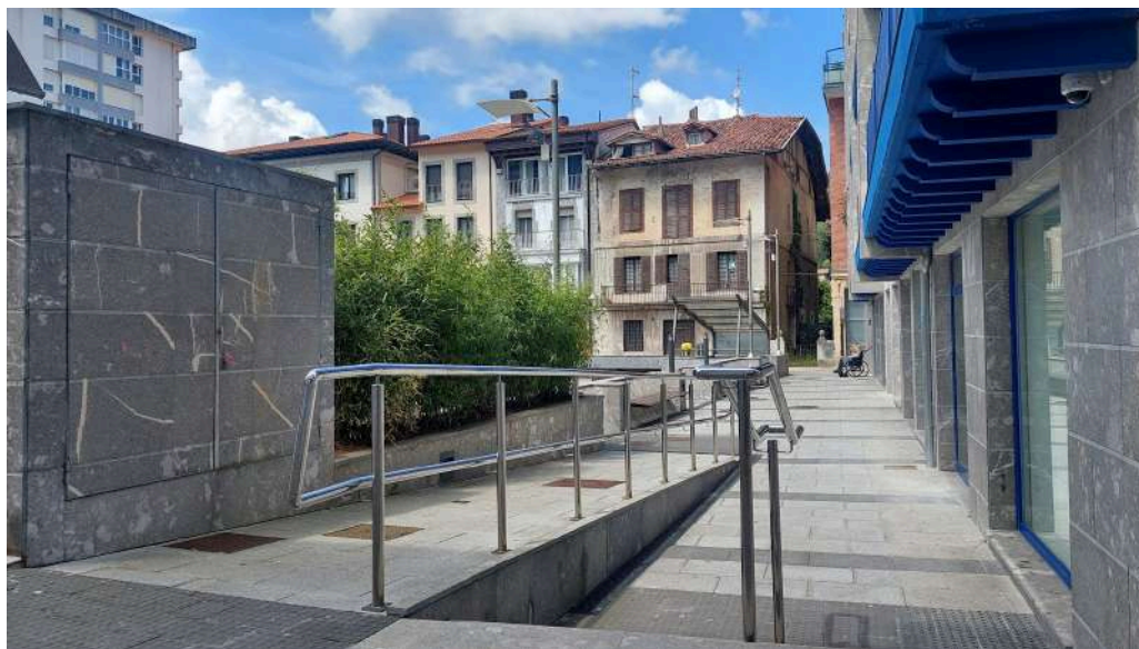
Eskubanda bikoitza alde bakarrean dago eta bere altuerak ez dira egokiak.
