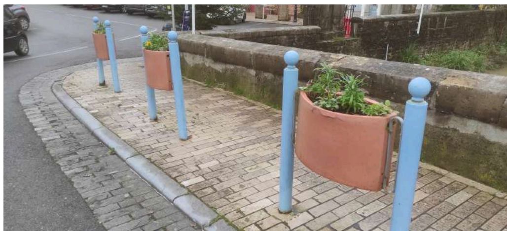
Elementu hauek mutiloien lana egiten dute, baina erraz detektatu daitezke, arriskuak ekidinez.
