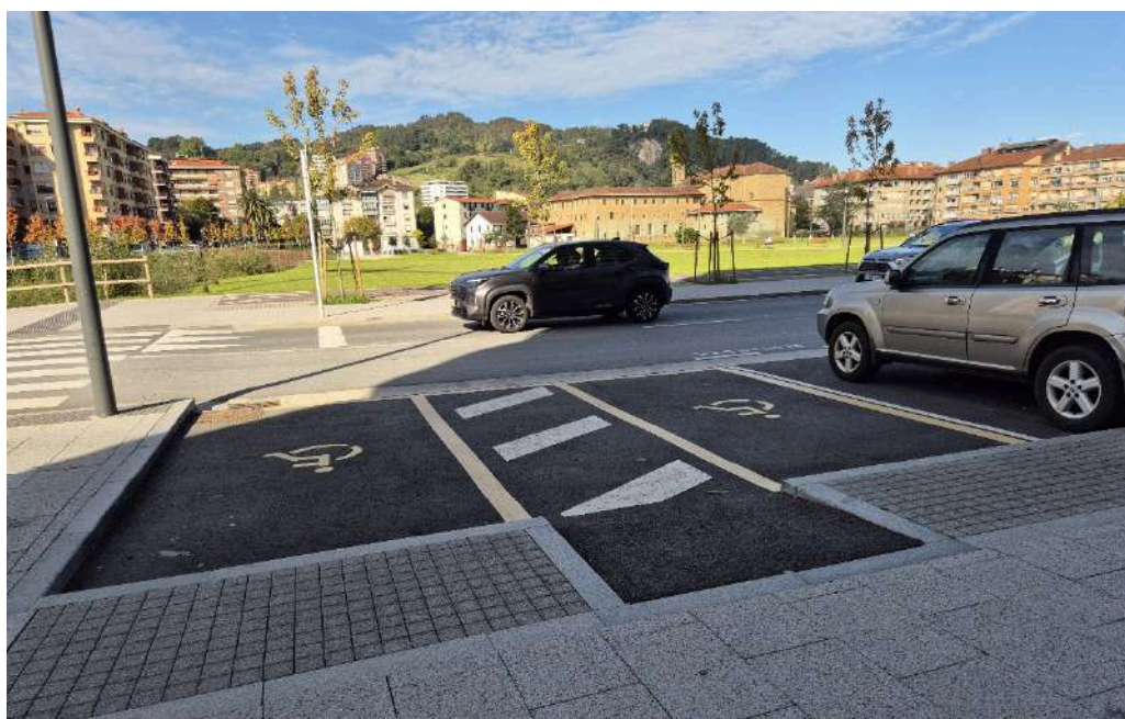
Goiko bi irudietan: Bi aparkaleku egokitu baterian: transferentzia-eremua partekatua da, eta ibia bertan eraiki da, asfaltozko arrapala baten bitartez. Zarautz.
