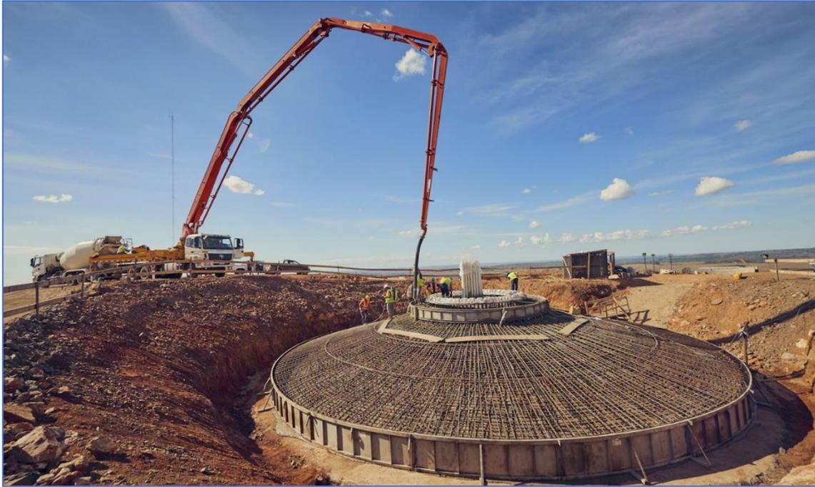
Proceso de hormigonado de una zapata y del pedestal para el soporte de la torre de un aerogenerador.
