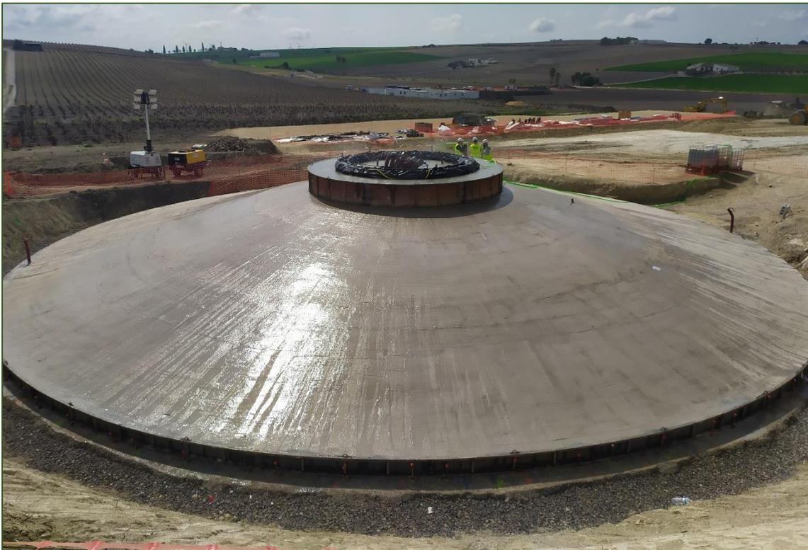
Zapata de hormigón y pedestal para el soporte de la torre del aerogenerador.
