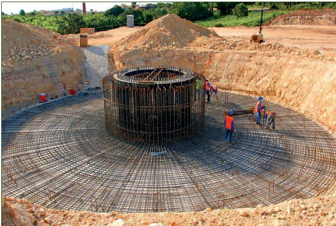
Estructura tipo de la zapata de hormigón y del pedestal para el soporte de la torre del aerogenerador.
